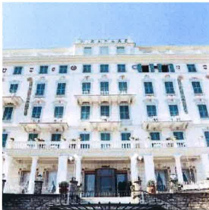
Il Grand Hotel Miramare di Santa Margherita
